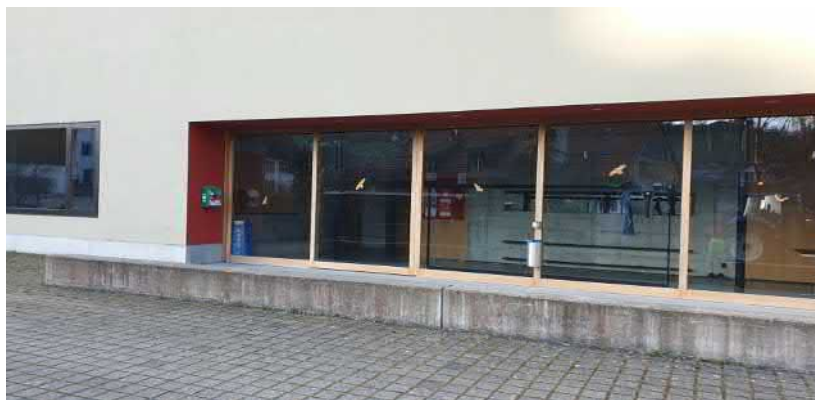
Zeglingen, Aussenwand Mehrzweckhalle
