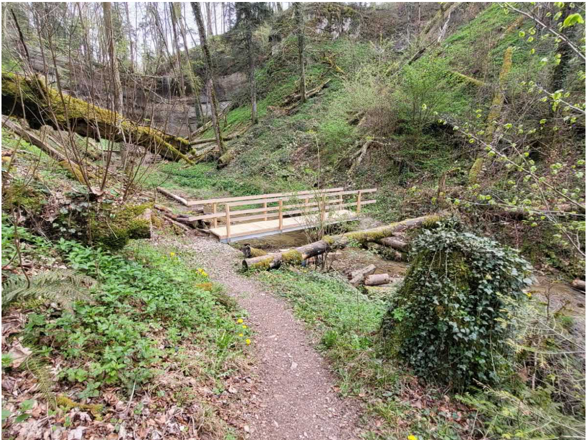
Die neue Brücke oberhalb des Kleinen Giessen.
