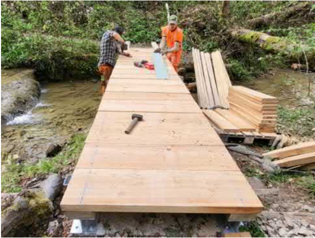
Die Brücke wird vor Ort montiert., Foto: Elia Geiger
