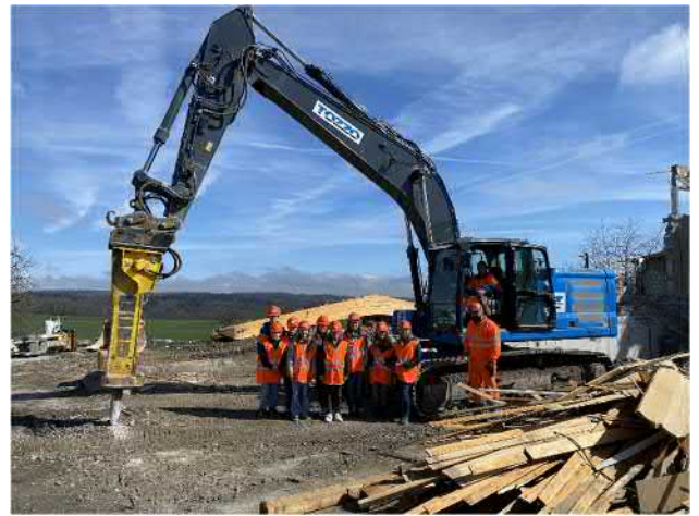
Schulklasse von Lehrerin Kathrin David auf «Baustellenexkursion»
