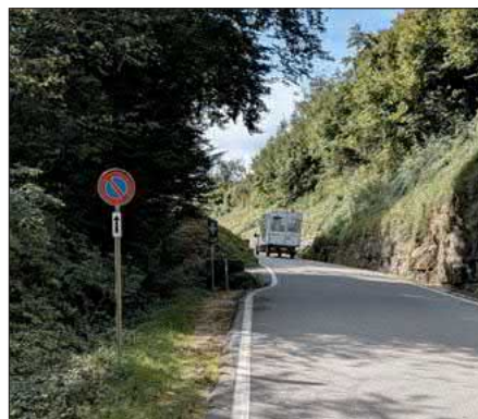
Gefährliche Stelle an der Hauptstrasse beim Giessen im Eital
